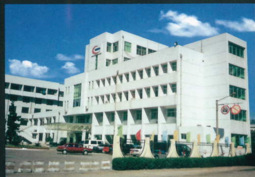
① 办公大楼外景
